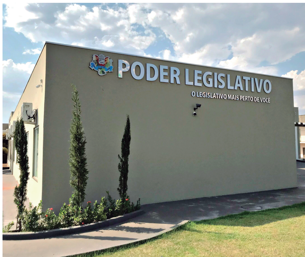
Prédio da Câmara Municipal de Caçu.
